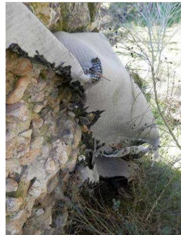
Detalles del deterioro provocado por la tela asfáltica a medio colocar y lo que parece imprimación asfáltica.
